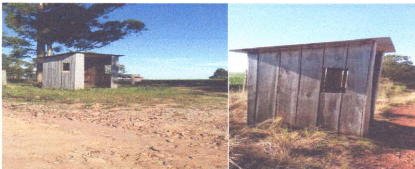
Foto construção de abrigos coletivos (paradas de ônibus).
