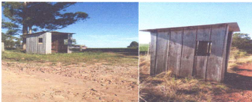
Foto construção de abrigos coletivos (paradas de ônibus).
