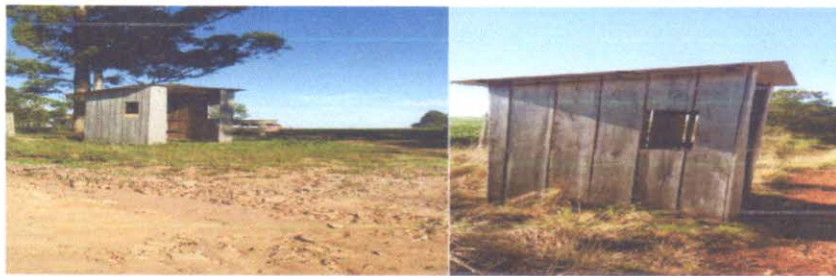
Foto construção de abrigos coletivos (paradas de ônibus).
