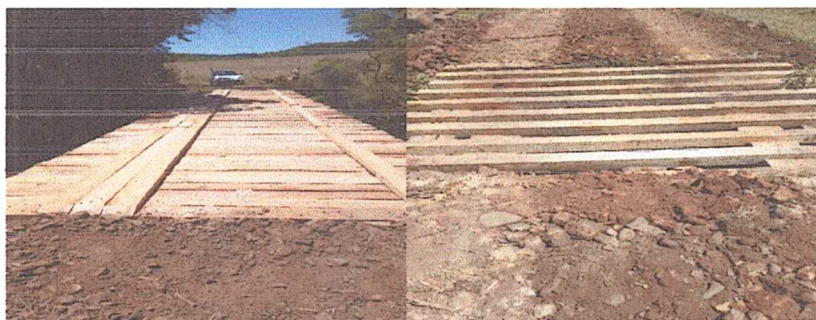
Foto da fabricação e manutenção de Pontilhões e Mata Burros.
